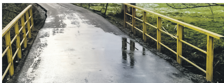
PRZEBUDOWA DROGI GMINNEJ W SOŁECTWIE JODŁOWA GÓRNA W MIEJSCOWOŚCI JODŁOWA OBEJMUJE ODCINEK O DŁUGOŚCI 350 M KOSZT 159 959,80 ZŁ DOFINANSOWANIE 127 967,00 ZŁ
