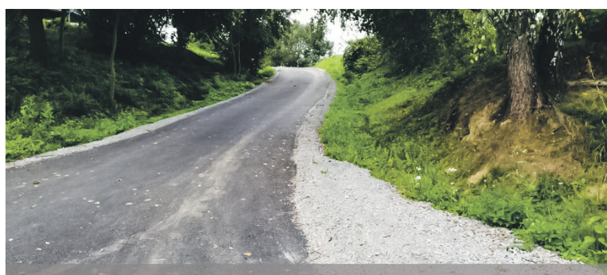
PRZEBUDOWA DROGI GMINNEJ „MROZOWA GÓRKA W STRONĘ PÓŁNOCNĄ” O NR EWID. 1308 W KM 0+000 - 0+150 W MIEJSCOWOŚCI JODŁOWA
