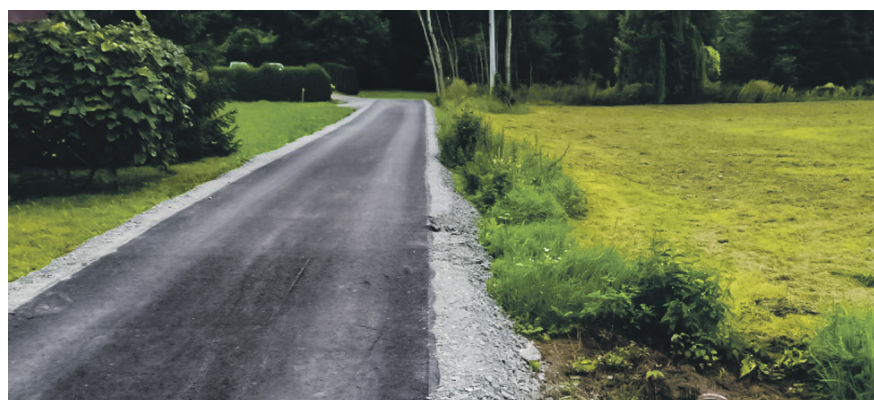
PRZEBUDOWA DROGI GMINNEJ ZA PIEKARNIĄ -K. DROGI PAŃSKIE ŁĄKI
