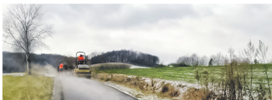
REMONT DROGI GMINNEJ ZLOKALIZOWANEJ W MIEJSCOWOŚCI DĘBOWA (PRZY DRODZE POWIATOWEJ RELACJI DĘBOWA-CZERMNA) OBEJMUJE ODCINEK O DŁUGOŚCI 600 M KOSZT 298 611,65 ZŁ DOFINANSOWANIE 238 889,00 ZŁ
